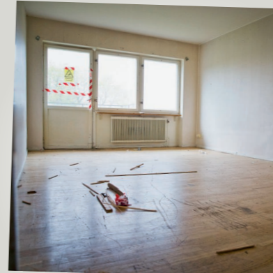
Tomt. Ett parkettgolv i rivningskåken har brutits upp.
